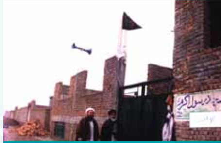
مسجد الرسول الأكرم ﷺ قيد البناء
